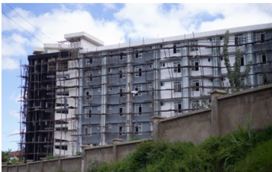
Rohbau des neuen Maternity Hospital
